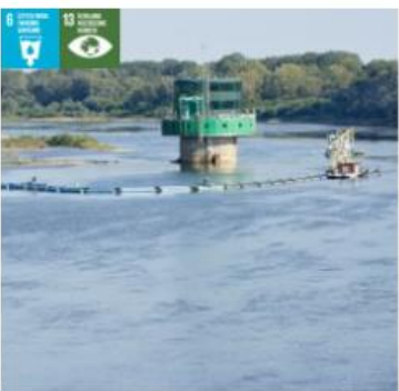
Modernizacja ujścia zasadniczego "Gruba Kaśka" oraz tunelu pod dnem Wisły Usługa: Projektowanie "Gruba Kaśka" to największa tego typu studnia w Europie wykorzystująca naturalny proces infiltracji
