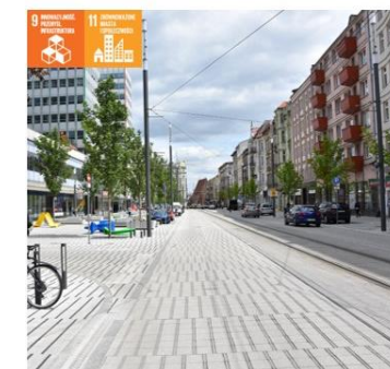
Rozbudowa ul. Święty Marcin i Planu Wolności w Poznaniu w ramach Projektu Centrum Usługa: Nadzór
