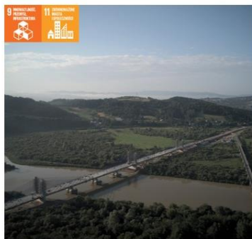
Most w Kurowie nad Dunajcem Usługa: Projektowanie Jeden z najdłuższych mostów typu "extradosed" w Polsce
