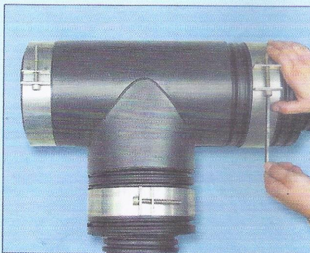
Założyć górny element na rurociąg i mocno skręcić kluczem imbusowym opaski z blachy kwasoodpornej
